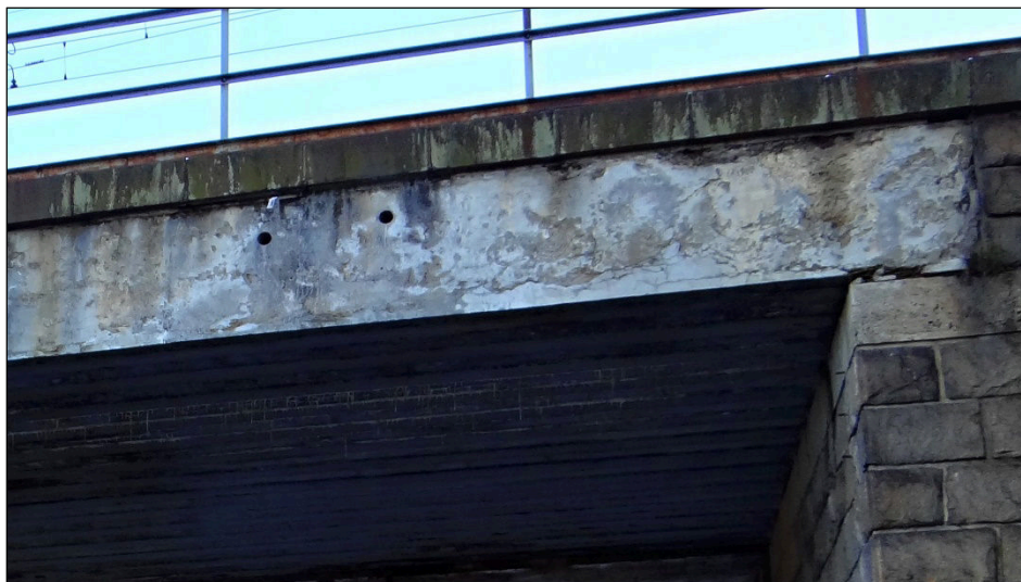
Obr. 15 Degradace bočních povrchových vrstev nosné konstrukce vlivem vlhkosti
