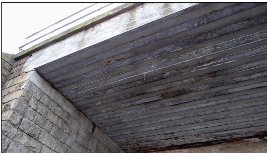
Obr. 14 Výluhové krápníky, výkvěty a zatečení nosné konstrukce
