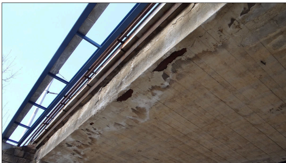
Obr. 16 Odpadávání povrchových vrstev betonu
