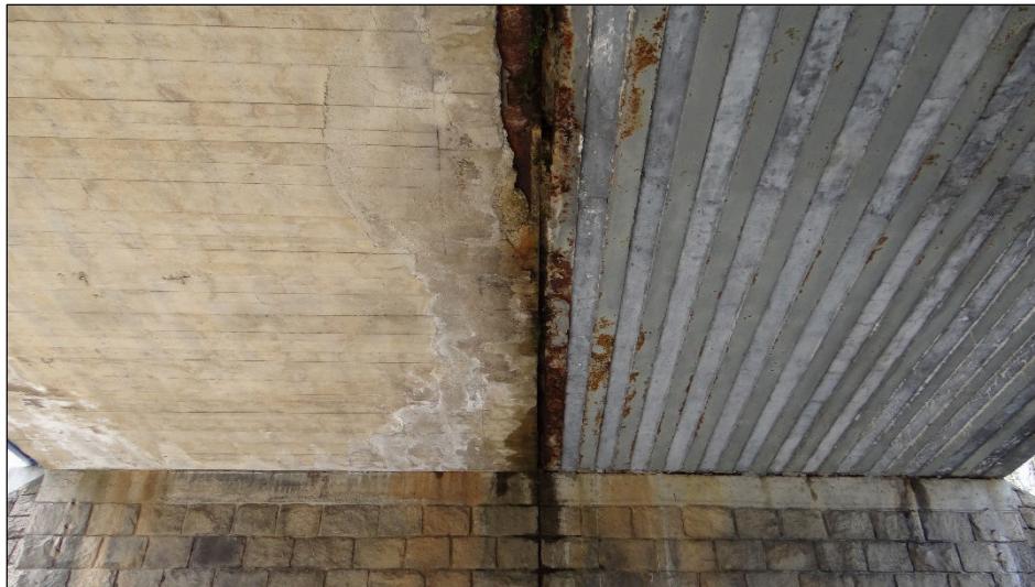
Obr. 17 Zatékání skrze dilatační spáru a koroze I nosníků
