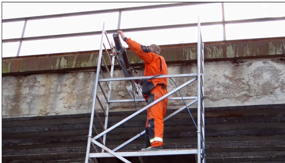
Obr. 8 Vrtání diamantovou korunkou s vodním výplachem
