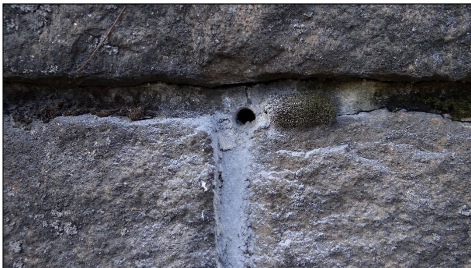
Obr. 13 Vrtaná sonda ve spáře mezi žulovými bloky v OP2
