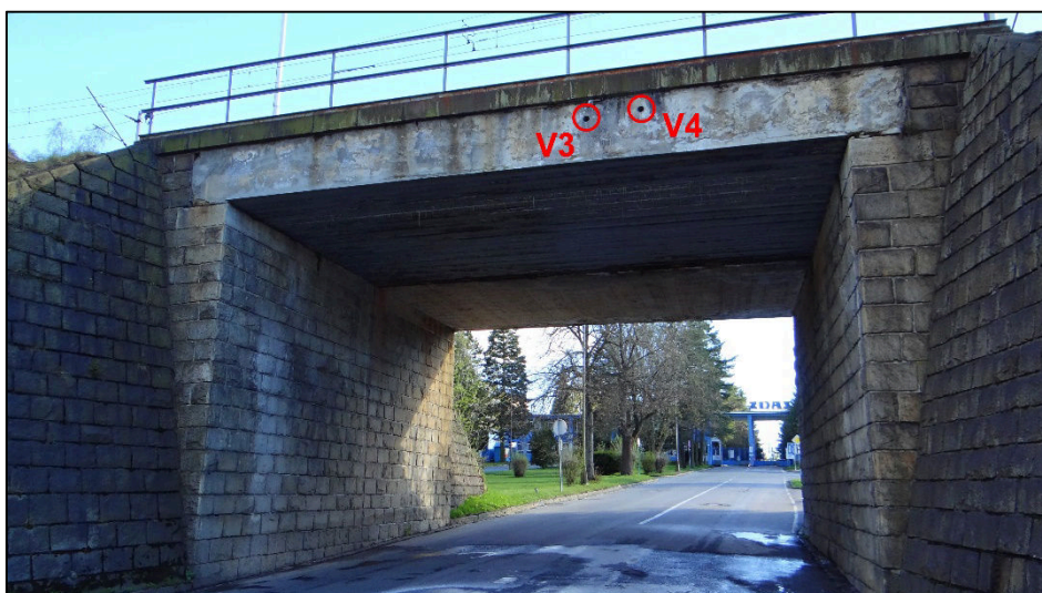
Obr. 10 Pohled na místa odběru vrtů V3 a V4
