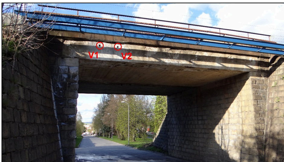
Obr. 9 Pohled na místa odběru vrtů V1 a V2
