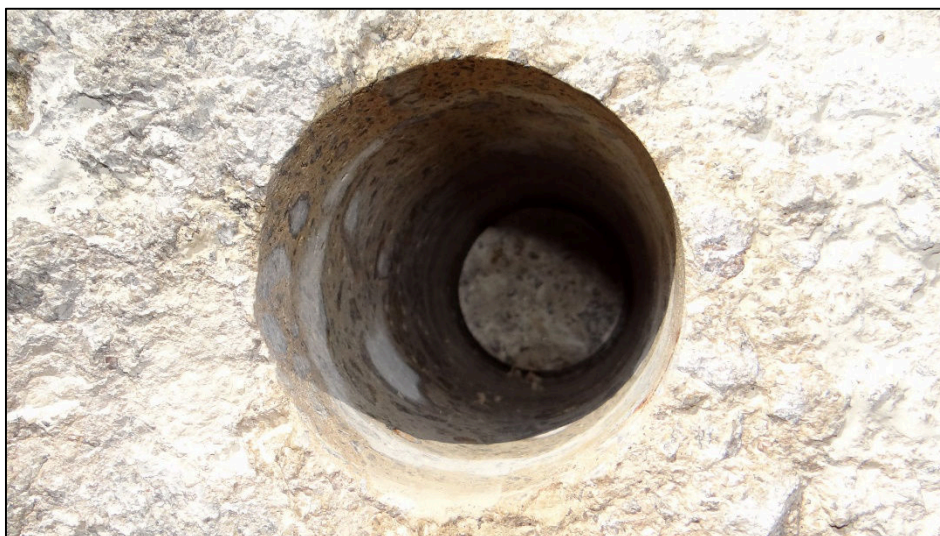
Obr. 11 Pohled do dutiny po vrtání jádrového vrtu V1
